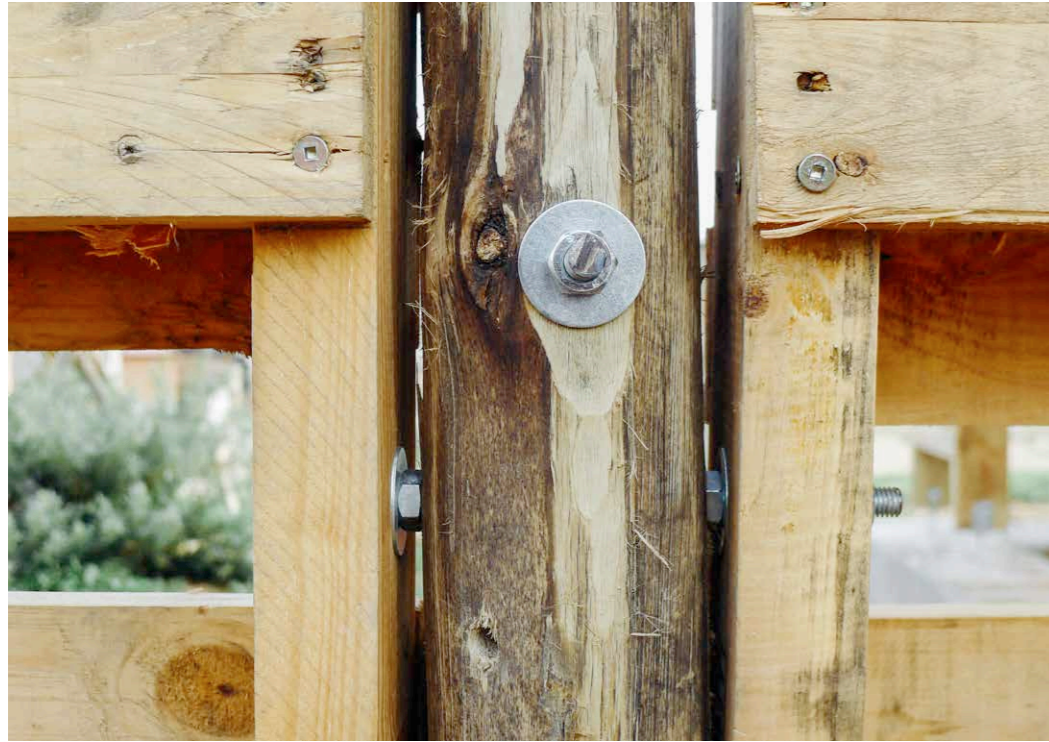
Detailanschluss Stütze
