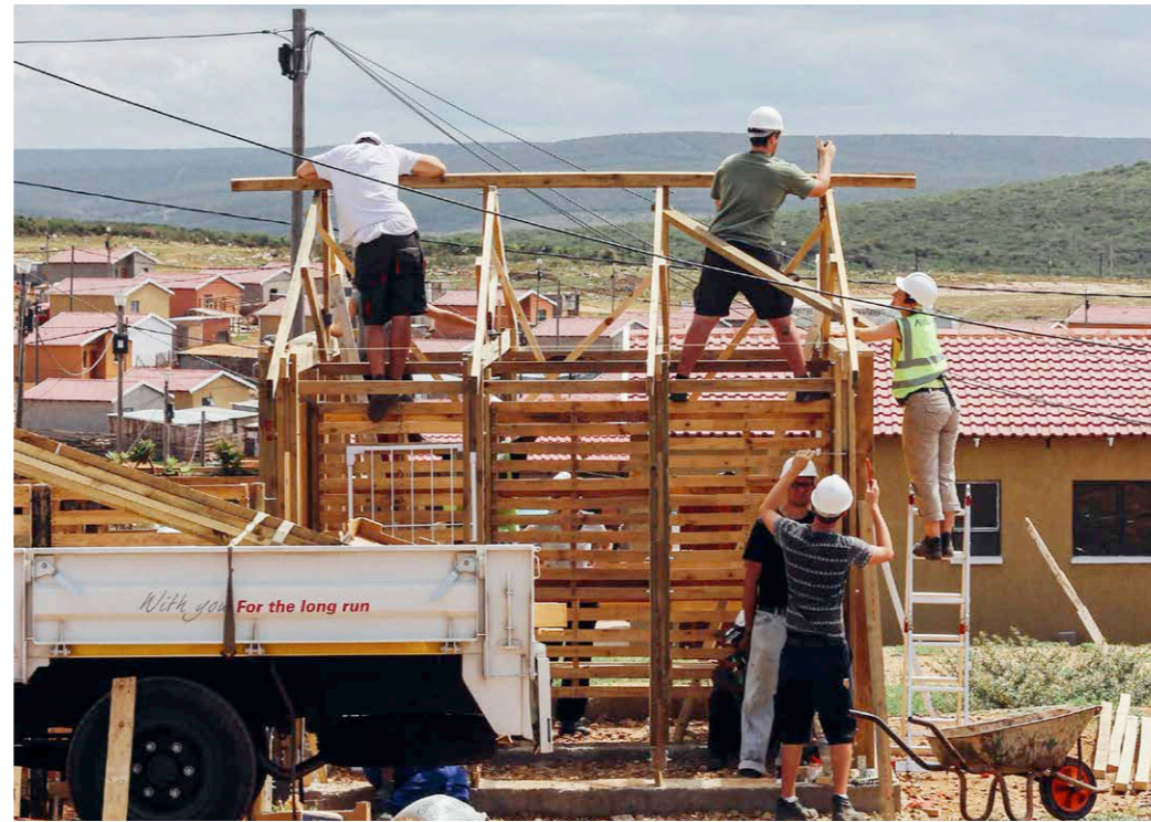
Ausrichten der Dachbinder
