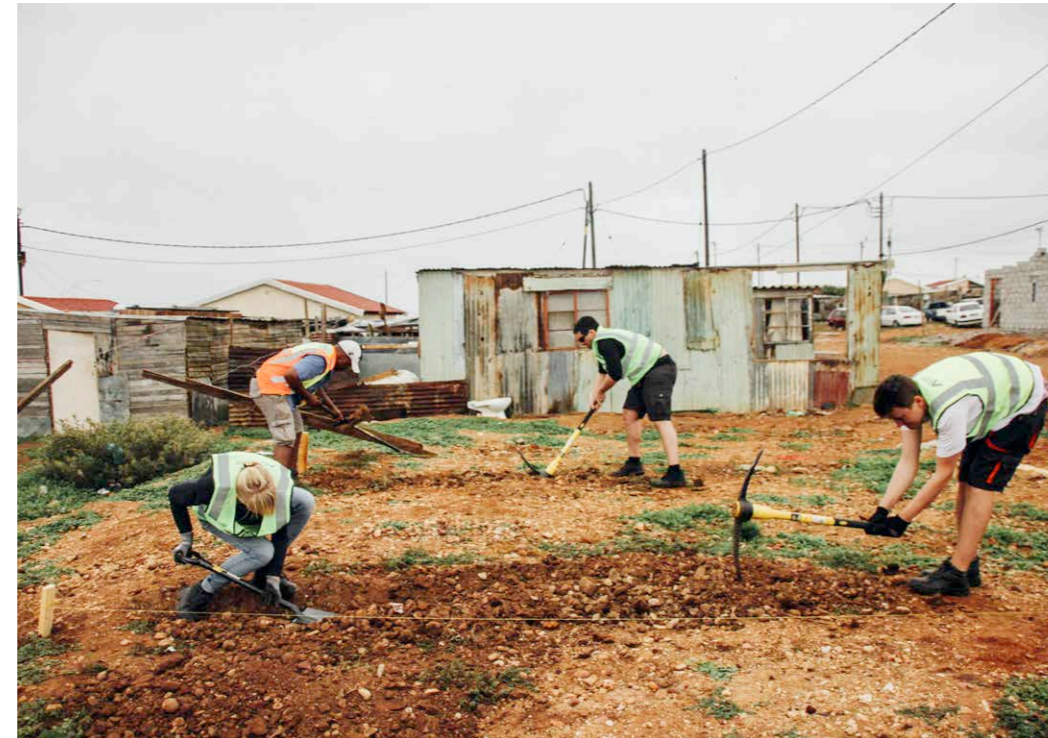
Herstellung der Fundamentgräben
